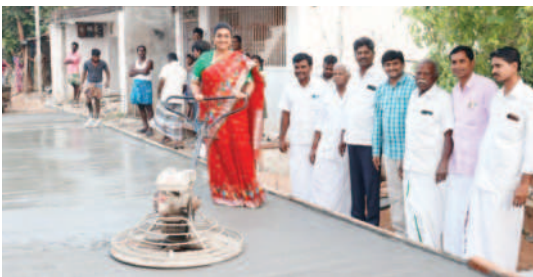
సిమెంటు రోడ్డు పనులను ప్రారంభిస్తున్న మంత్రి రోజా
